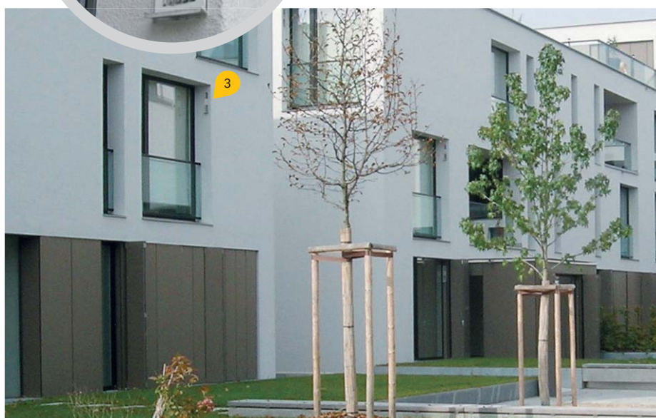
Immagine 11.3 Resta visibile solo una discreta copertura di facciata nell'intradosso della finestra
