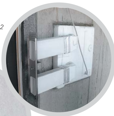
Immagine 11.3 Resta visibile solo una discreta copertura di facciata nell'intradosso della finestra
