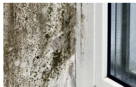
Immagine 7.1 Forte manifestazione di muffa in seguito ad un'aerazione sbagliata.
