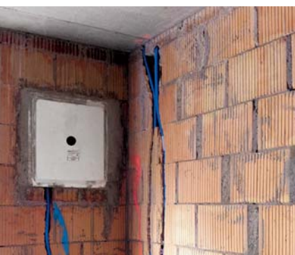
Immagine 16.1 Cassetta a muro per montaggio sotto intonaco secondo immagine 16.2, montata nel muro esterno. Il bordo guida permette una lavorazione pulita durante l'applicazione dell'intonaco. Esiste anche una variante per strutture di supporto (senza bordo guida).
