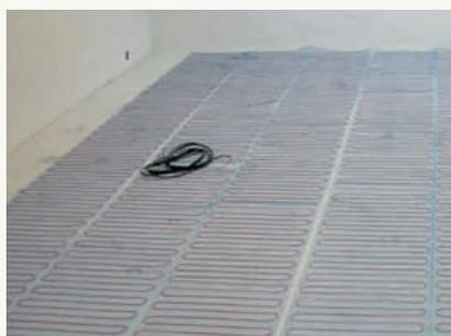
*Rete riscaldante posata direttamente sotto il rivestimento del pavimento*
