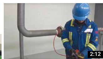
Installation du kit de terminaison nVent RAYCHEM E-100
