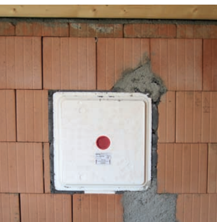
Bild 14.1: Möchten sie erst später eine Lüftung einbauen, so montieren sie mindestens die Montageboxen in die Aussenwand. Dadurch ist ein späterer Geräteeinbau völlig einfach und ohne bauliche Massnahmen möglich
