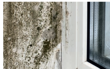
Bild 7.1 Starker Schimmelbefall durch falsches Lüften
