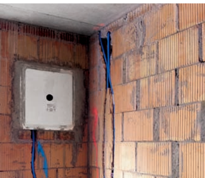
Bild 16.1 Mauerkasten gemäss Bild 16.2, eingebaut in die Aussenwand. Die vorstehende Putzkante ermög- licht eine saubere Verarbeitung beim Auftrag des Putzes. Es ist auch eine Variante für Stän- derkonstruktion (ohne Putzkante) erhältlich.
