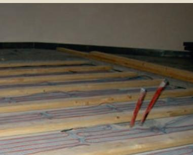
*Netzheizmatte zwischen Balkenlage verlegt*
