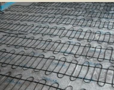
*Fussbodenheizung im Unterlagsboden*
