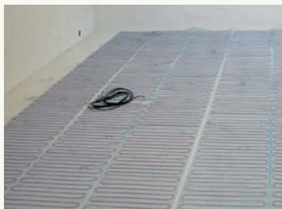
*Netzheizmatten direkt unter dem Bodenbelag verlegt*
