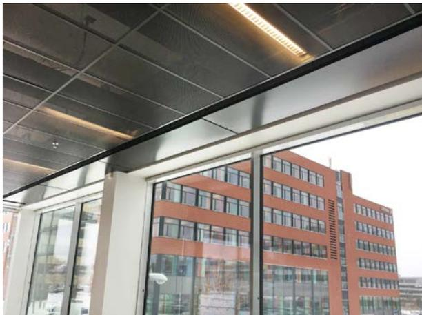
Wärmestrahler sind der perfekte Schutz vor Zugluft. Hier werden die Fenster durch einen hängenden Aquaztrip Plan mit schwarzer Oberfläche geschützt.
