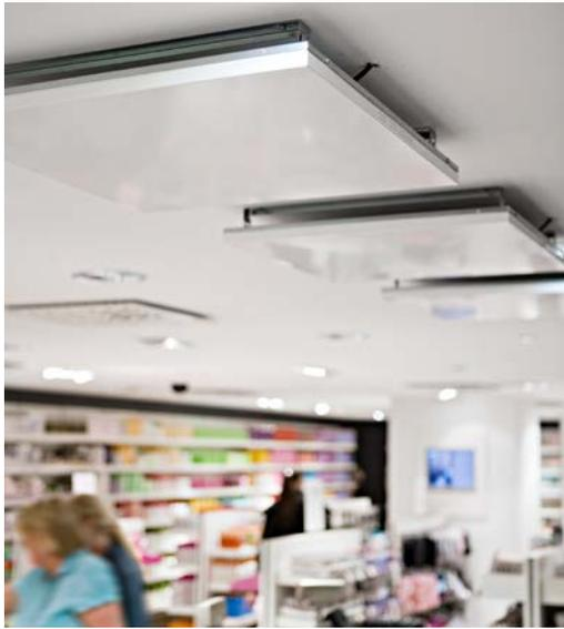
Die Deckenmontage schützt die Thermocassette gegen Beschädigungen.
