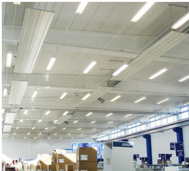
Aquaztrip kann sowohl für die Vollheizung als auch die Zonenbeheizung verwendet werden. Dies ist sowohl praktisch als auch energiesparend in Werkshallen.
