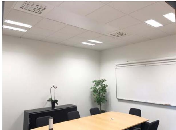
Durch das Strahlungsprinzip wird die Luft nicht direkt erwärmt. Dies gewährleistet ein angenehmes, zugluftfreies Raumklima mit gleichmäßiger Temperatur.
