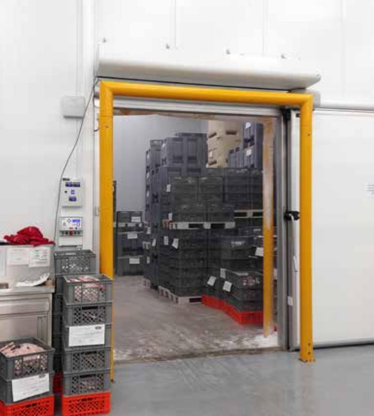
Unabhängige Tests haben ergeben, dass korrekt installierte Luftschleier den Energieverlust an einer offenen Tür um bis zu 80 % reduzieren können. Ein korrekt installierter Luftschleier deckt die Öffnung ihrer Breite und Höhe nach ab und ist auf die Belastungen zugeschnitten, denen sie ausgesetzt ist.
