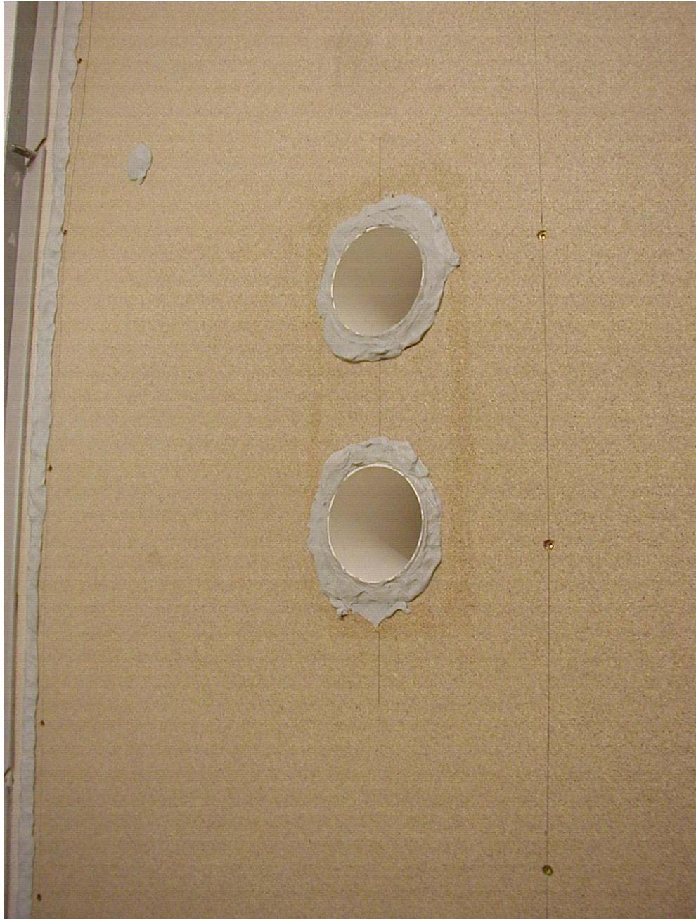
**Ansicht der Zu- und Abluftöffnungen mit Standard-Fassadenabschluss aus Kunststoff vom Empfangsraum**
