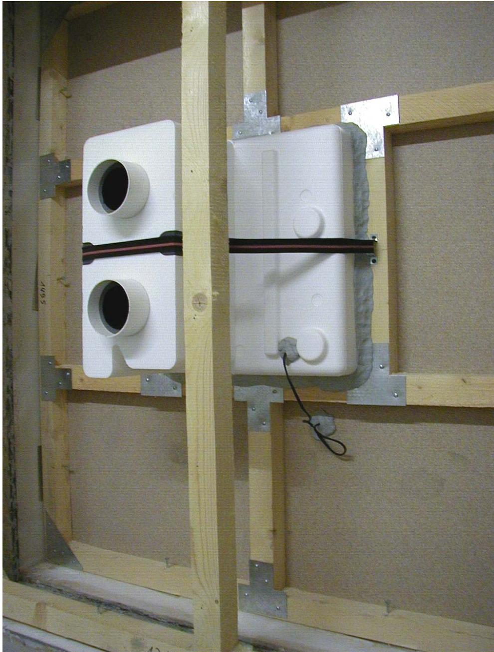
**Ansicht der Zu- und Abluftöffnungen ohne Fassadenabschluss vom Empfangsraum**
