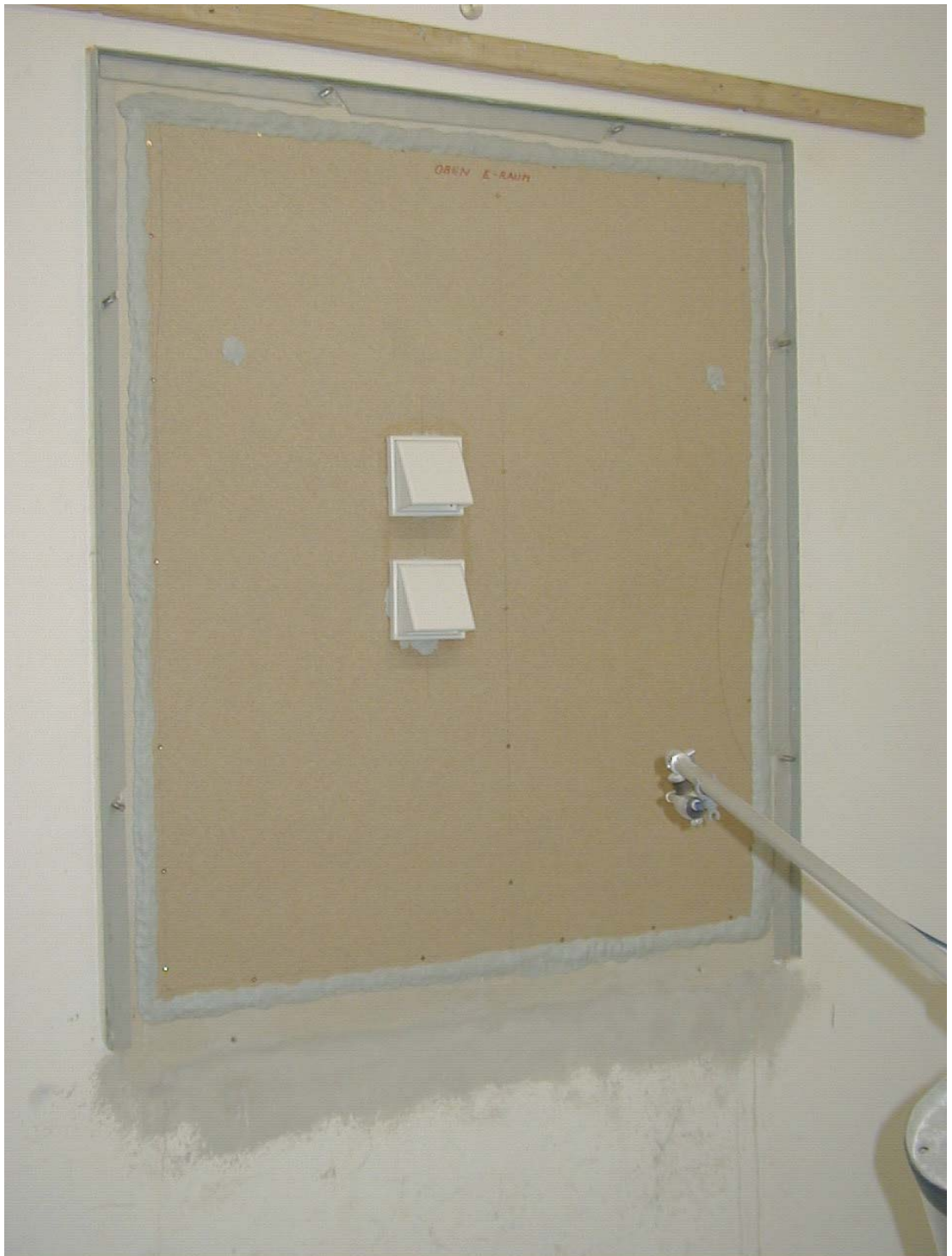
Ansicht der Trockenbaukonstruktion mit Lüftungsgerät von der vom Hallraum abgewandten Seite
