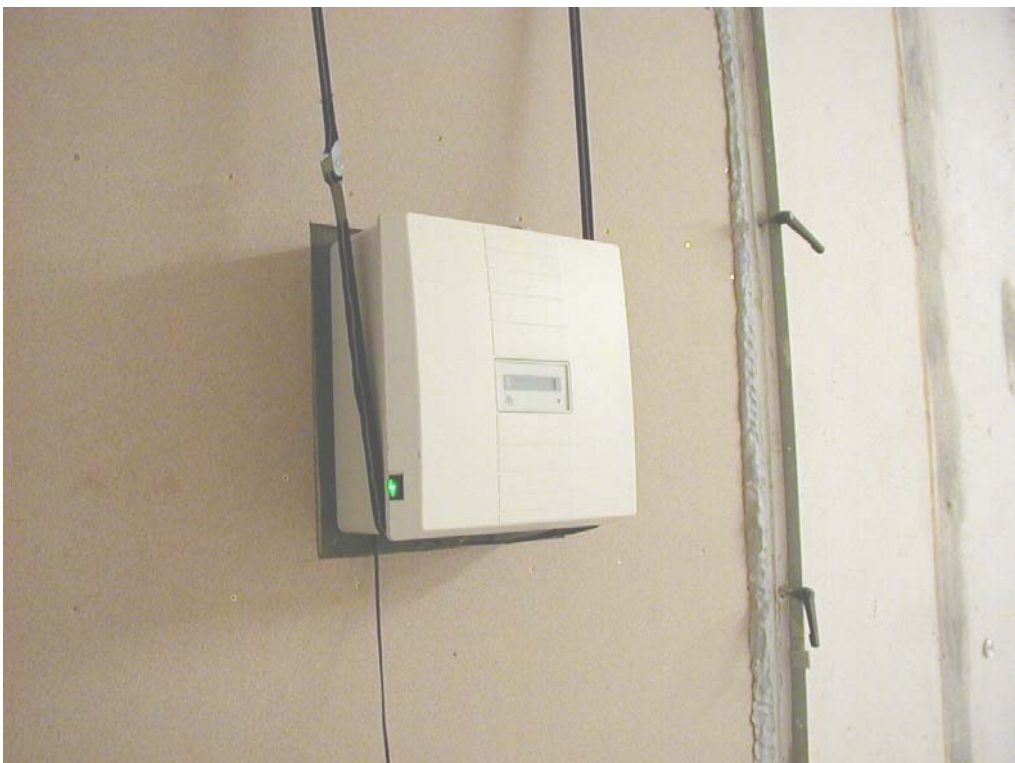
Ansicht der Trockenbaukonstruktion mit Lüftungsgerät M-WGR-S / K UP (Ausführung Unterputz) vom Hallraum
