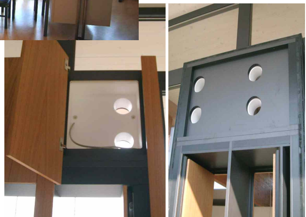
Installation im Oberlichtbereich
