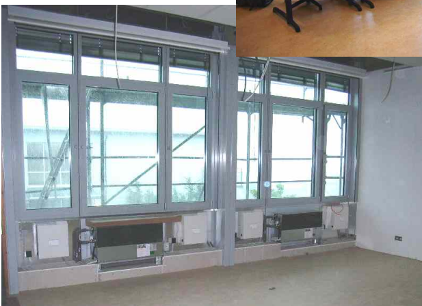
Installation im Brüstungsbereich
