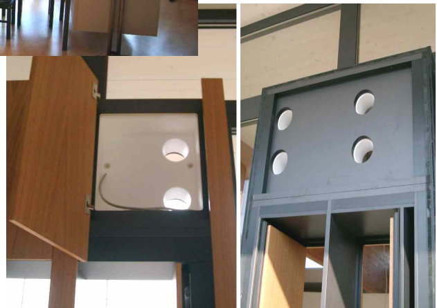
Installation im Oberlichtbereich
