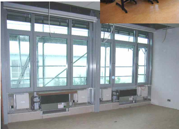
Installation im Brüstungsbereich
