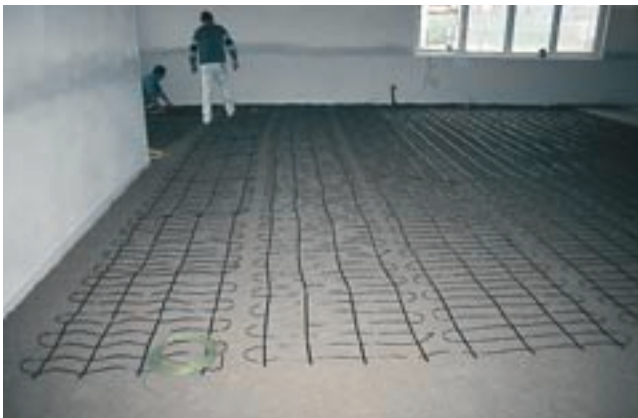
Einfach auslegen auf die roh abgezogene erste Unterlagsbodenschicht – dann den Unterlagsboden fertigstellen.
