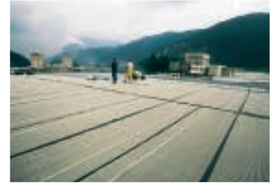
Matten werden gemäss ETHERMA-Verlegeplan aufgelegt.
