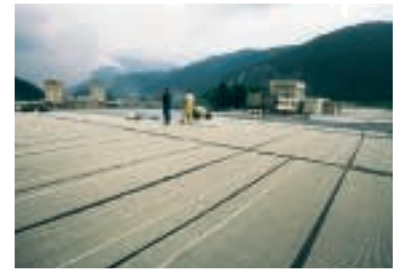
Matten werden gemäss ETHERMA-Verlegeplan aufgelegt.
