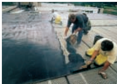
Der Gussasphalt wird per Hand aufgeschüttet und verstrichen.
