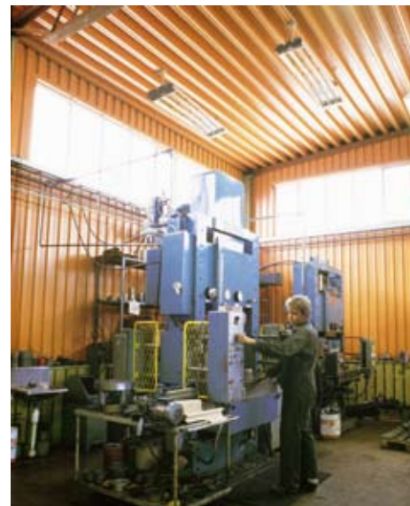
Mit IR-Wärmestrahlern kann die Temperatur in unterschiedlichen Raumbereichen perfekt angepasst werden. Punktuelleres Heizen erhöht den Komfort und verringert die Heizkosten.
