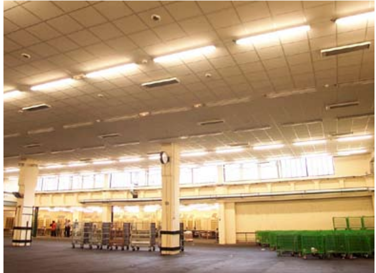
Wärmestrahler geben die Wärme an Oberflächen wie Personen, Böden und Einbauten ab. So wird auch in Räumen mit großem Volumen ein angenehmes Raumklima erreicht.
